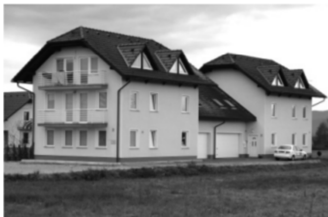
Zgradili so tudi večstanovanjski objekt na lžanski cesti
